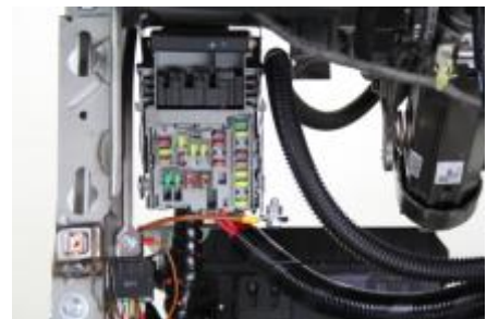
Abbildung zeigt den Sicherungskasten
