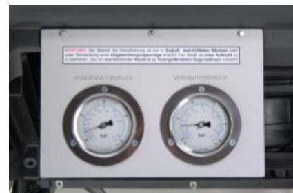
Abbildung zeigt die Anzeigen für Kondensator- und Verdampferdruck
